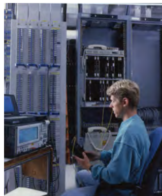
Halldór Guðmundsson tæknifræðingur við mælingar á ljósleiðarakerfi.
